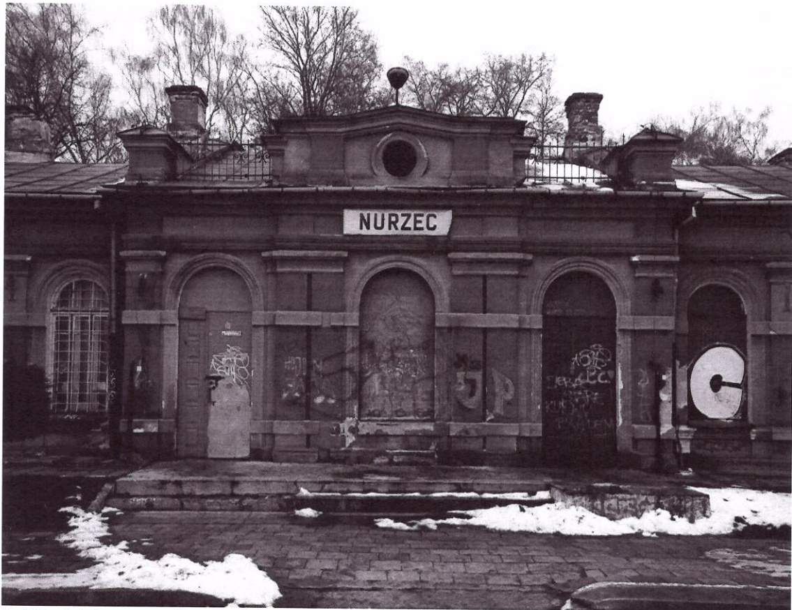
Fot.3 widok na ryzalit południowy
