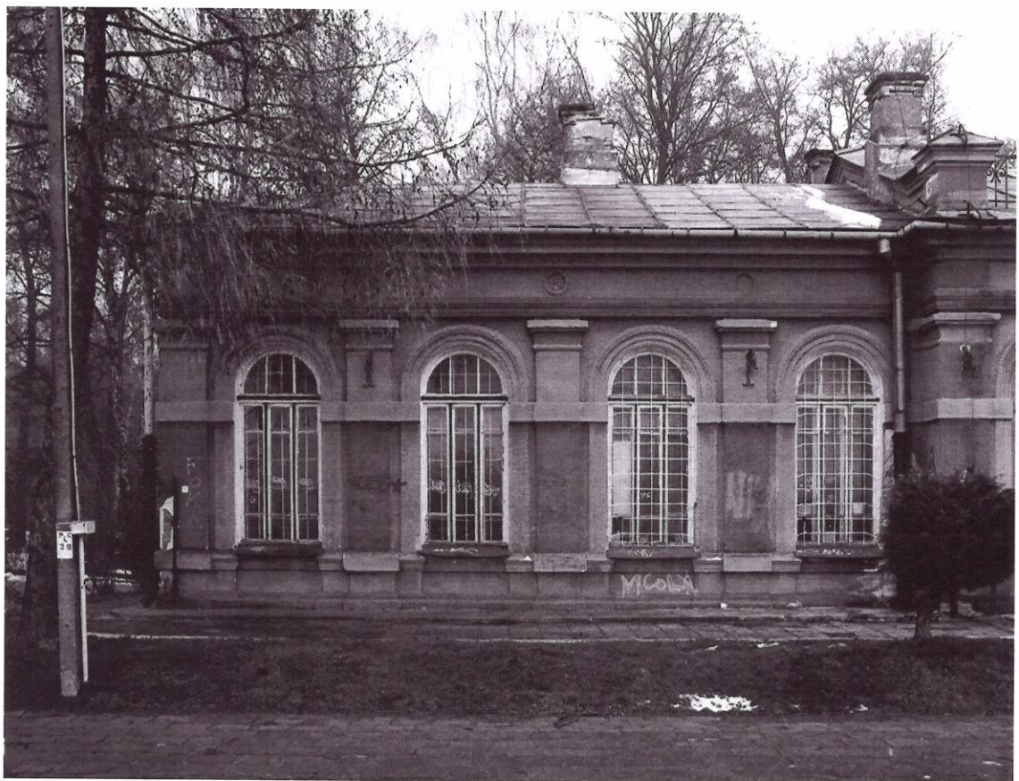
Fot.4 elewacja południowa zachodniego skrzydła
