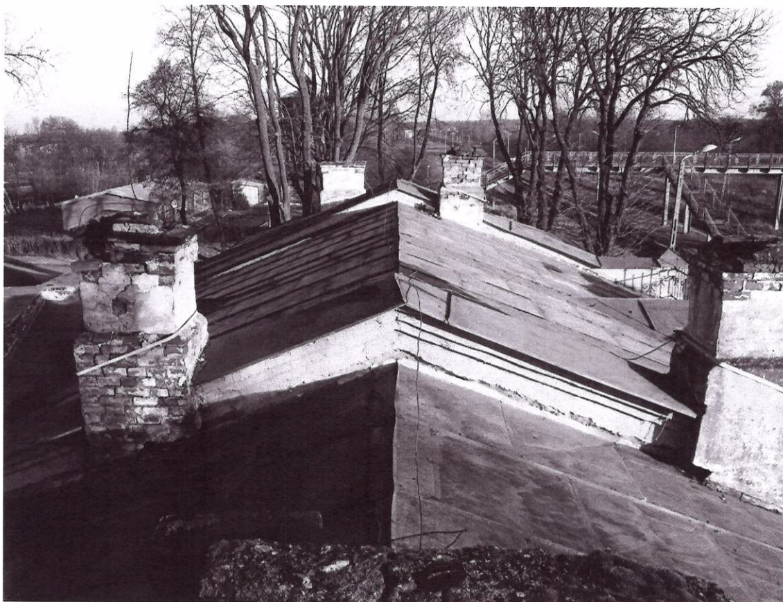
Fot.7 widok na dach
