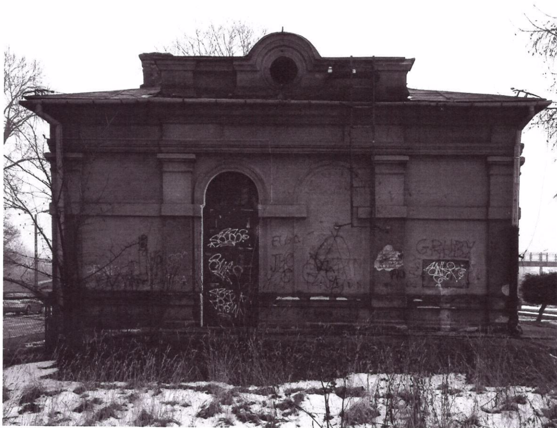
Fot.2 elewacja zachodnia
