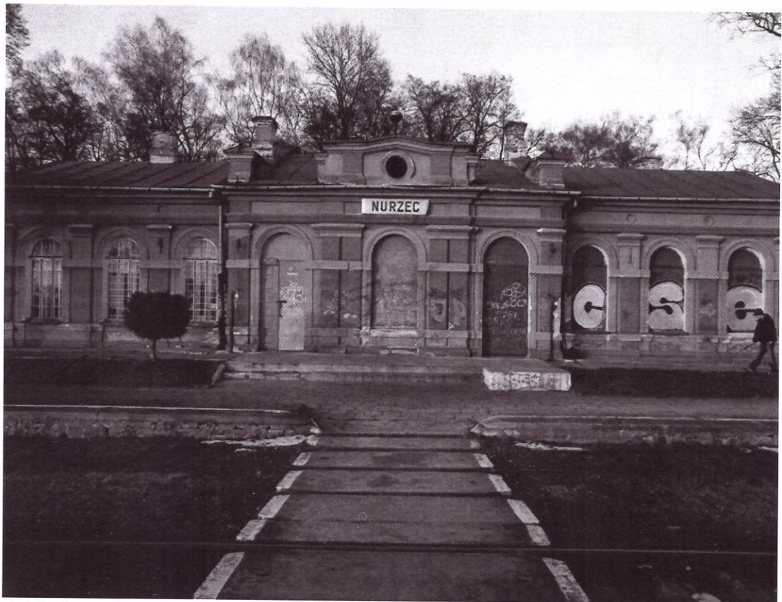
Fot.6 elewacja południowa
