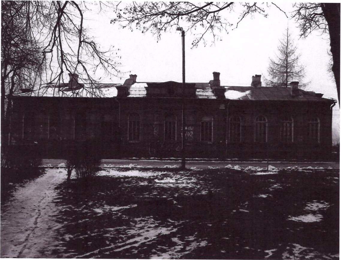
Fot.9 elewacja północna
